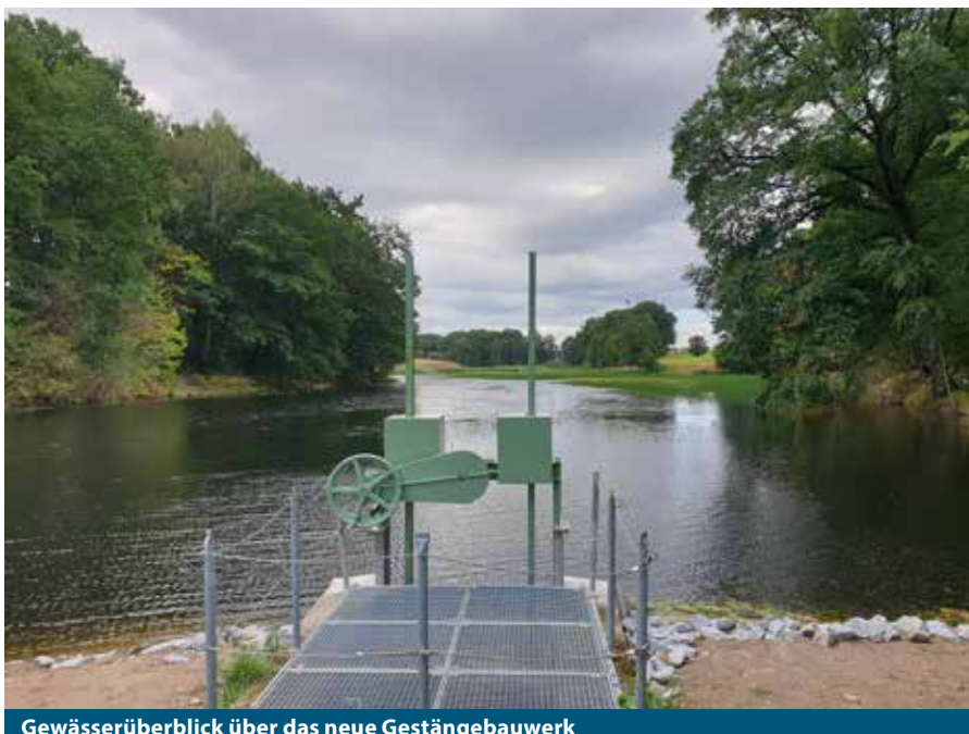
Gewässerüberblick über das neue Gestängebauwerk
