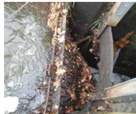
Unkontrolliertes Leerlaufen des Gewässers am 16.11.2022
